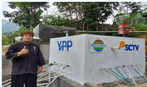
Pembangunan tandon air Sukabumi
